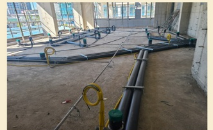
유론파이프 작업후 전원선 설치 작업
