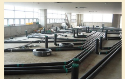
배관작업시 45도 사용하여 완만하게 작업하여야 연기배출이 잘됨
