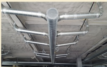
스파이럴 100φ사용하여 내부 천정에 앙카고정하여 외부배출하는 형식
