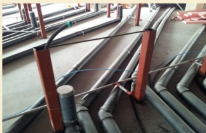
스파이럴 배관시공 250mm센타에 철사로 엘보를 고정 (콘크리트 못 양쪽사용)
