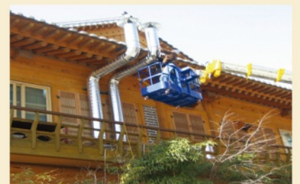
외부 300φ 직관에 엘보를 이용하여 외부로 뽑아내는 작업 형식
