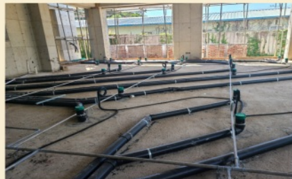
1차 유론파이프 작업후 가스배관 설치 작업
